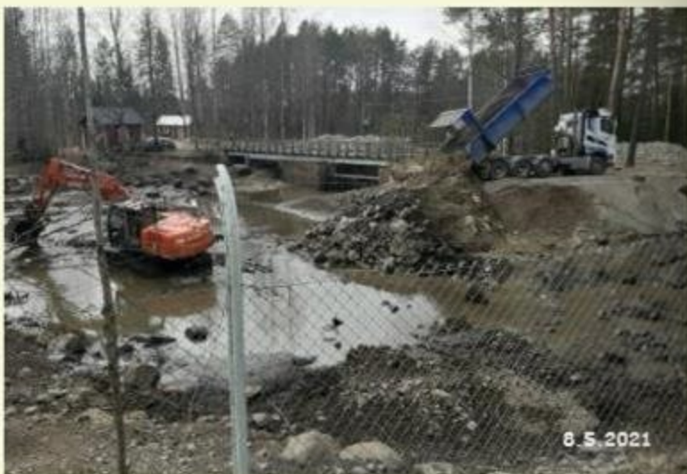
Lietettä poistetaan ja kuorma-auto tuo täyttemaata uoman reunoille.
