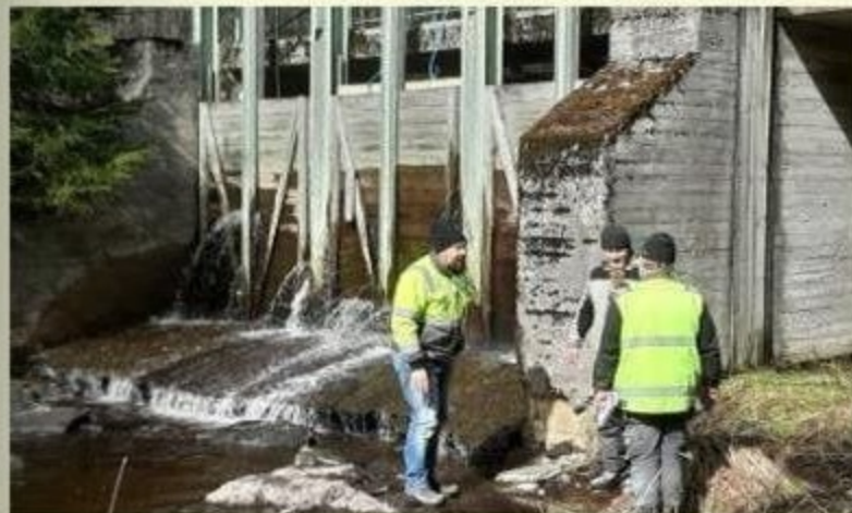
Kalaportin rakentajat suunnittelevat työvaiheita.
