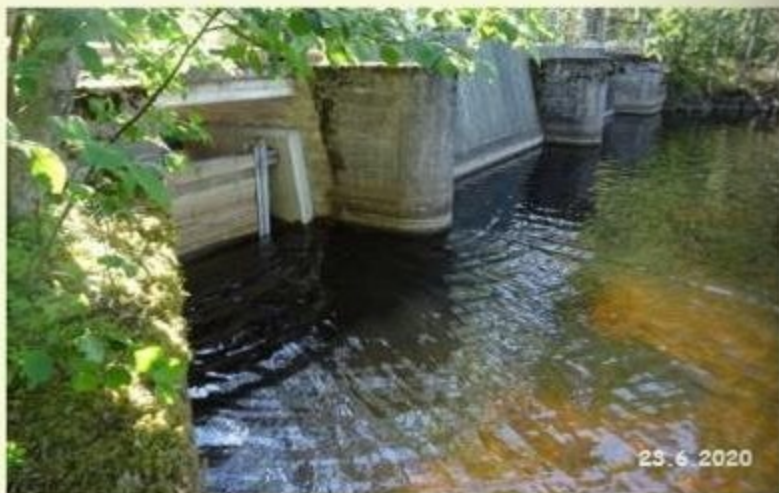
Kalaporras ja säännöstelypato Keiteleeltä katsottuna.
