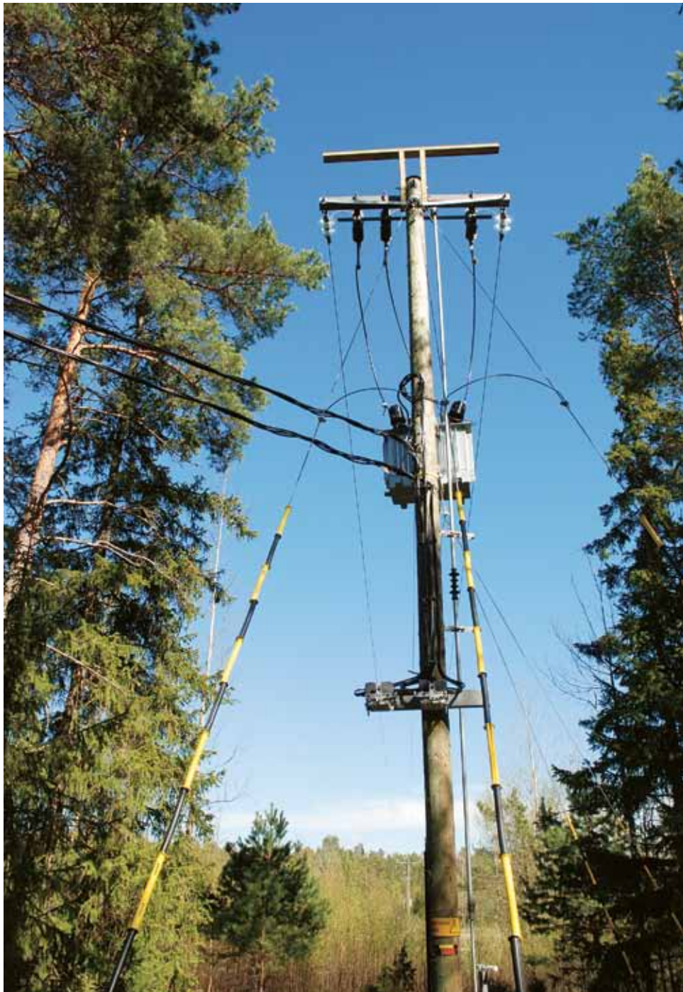
Suojaorrella varustettu sähköpylväs Kustavissa vuonna 2009.
