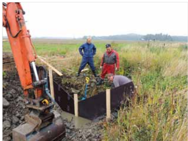
V-padon avulla lasketaan veden virtausta ja säännöstellään kemikaalin määrää.
